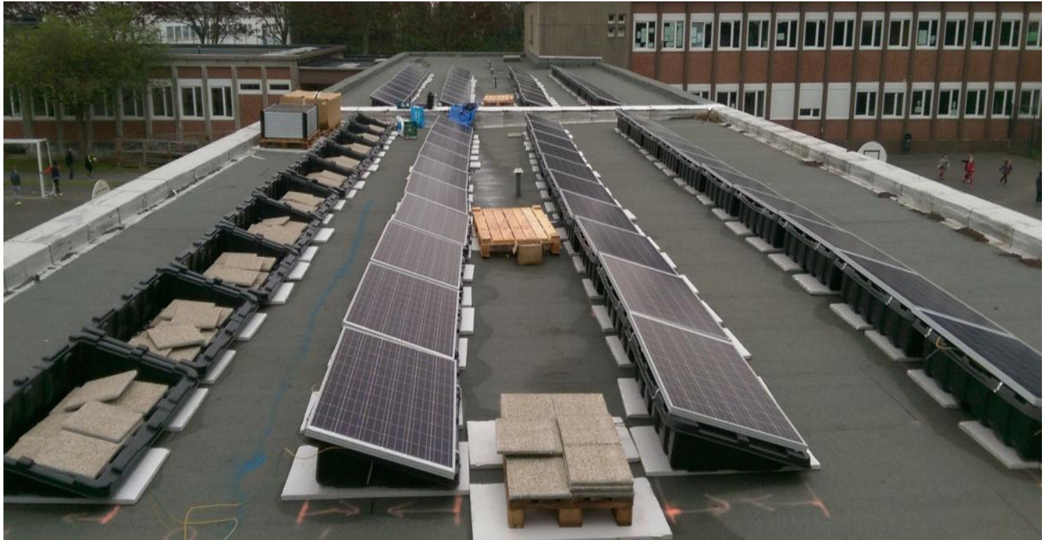
(photo: installation par les agents municipaux des panneaux solaires citoyens à l'école de Kersabiec le 12/05/2016)
